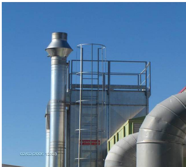
accesso con scala fissa ed uso come piattaforma della parte superiore del filtro a maniche opportunamente dotato di regolare parapetto
