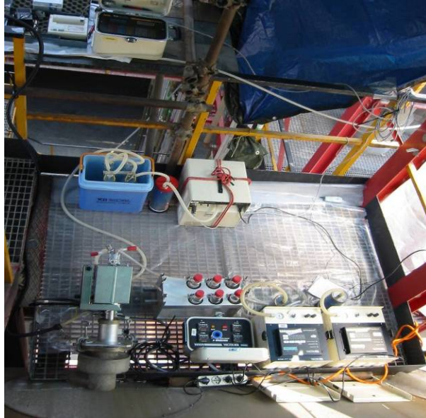
Postazione di dimensioni sufficienti
