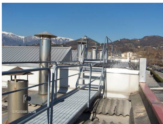
Collegamento che consente l'ispezione di tutti i camini
