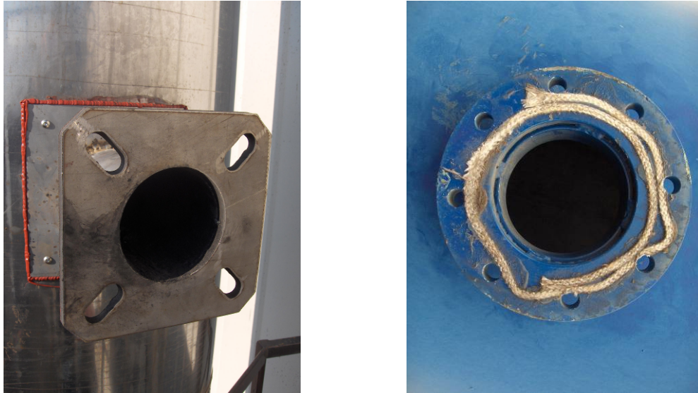
Esempio di tronchetti di prelievo da 4" flangiati
