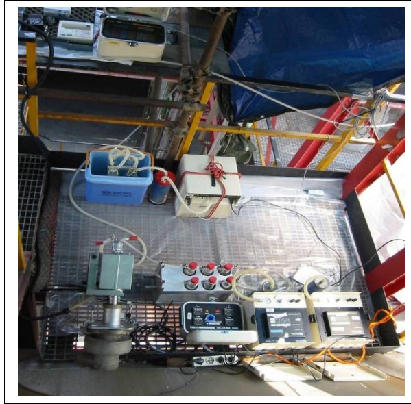
Postazione di dimensioni sufficienti
