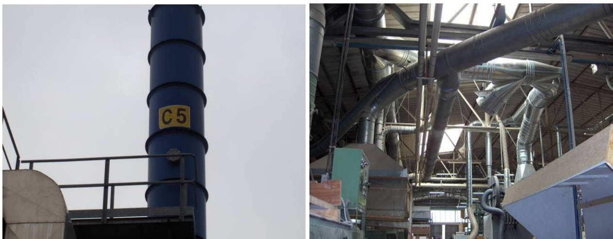
A sinistra un camino univocamente identificato (in riferimento al decreto di autorizzazione) e, a destra, un esempio di difficile identificazione di emissioni convogliate
