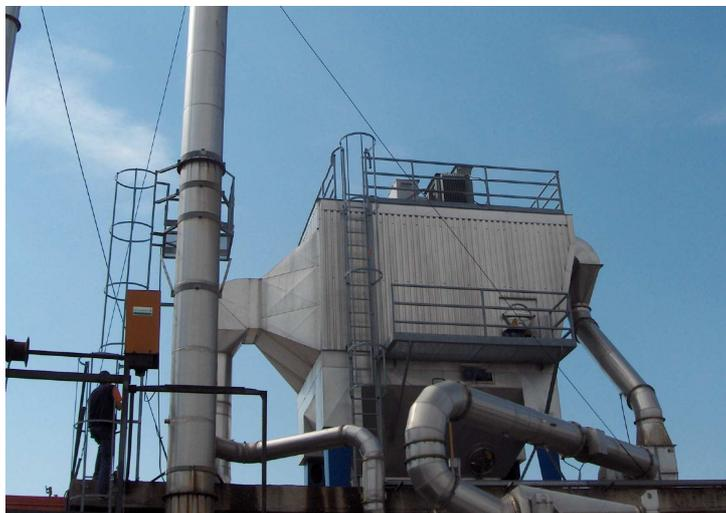
FOTO 7 – Depolverazione mediante filtro a maniche e recupero ceneri leggere
