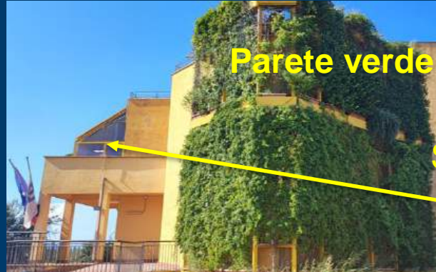
Edificio con la coltre vegetale
